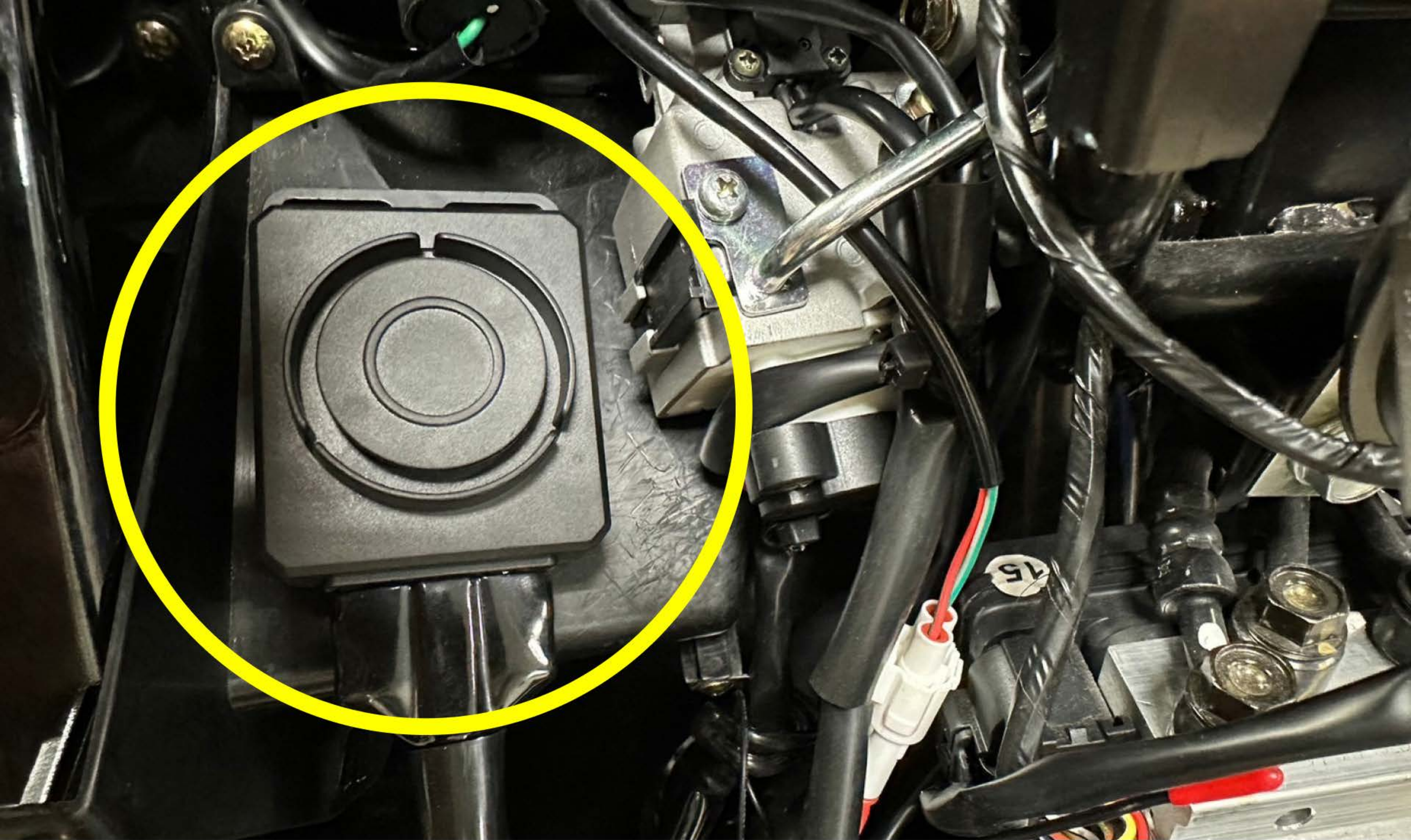
16 主機安裝位置
